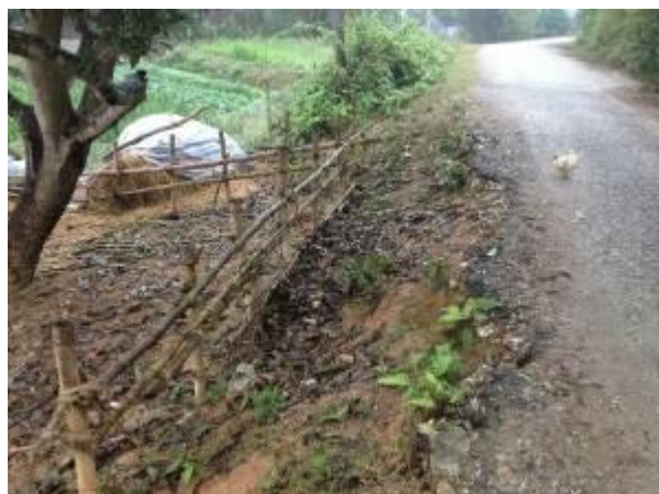
Hình 22: Đỉnh đập bong tróc và sạt lở bên vai trái
