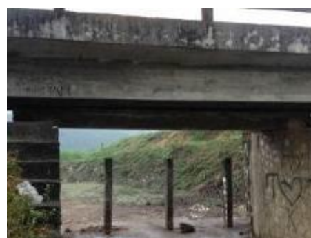
Hình 22: Đỉnh đập bong tróc và sạt lở bên vai trái
