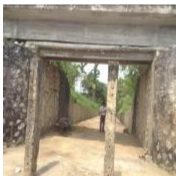
Tường của tràn xả lũ cao 3 m và cửa vào của tràn
