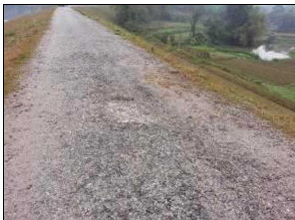
Hình 22: Đỉnh đập bong tróc và sạt lở bên vai trái
